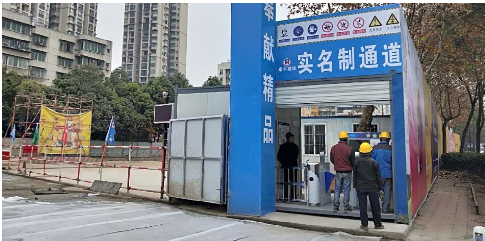
建筑工人正在刷脸卡进入工地
